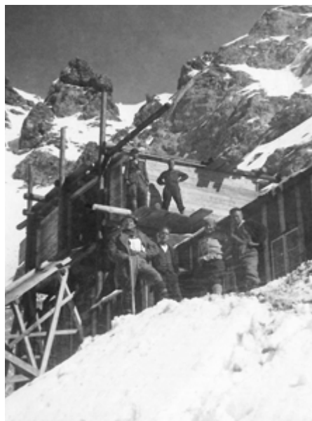
» Am Westabhang des Wettersteigkammes, auf 2.805 Metern Seehöhe unterhalb des Westgipfels der Zugspitze, fand man das ideale Gelände für die Errichtung der Bergstation.
