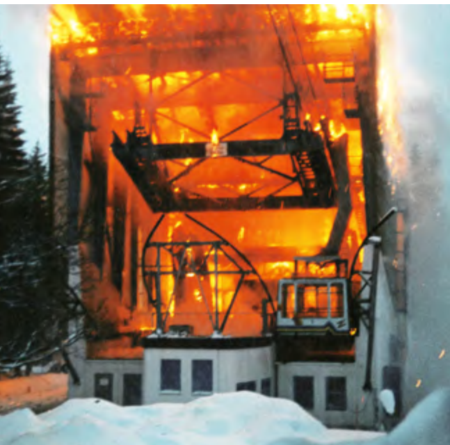
⚡ Beim Großbrand in der Talstation wurden das Gebäude und auch die Seilbahnanlage selbst zerstört.
